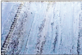
टोहाना। भाखड़ा नहर में लाइनिंग का कार्य होने के बाद दिख रही बजरी।
